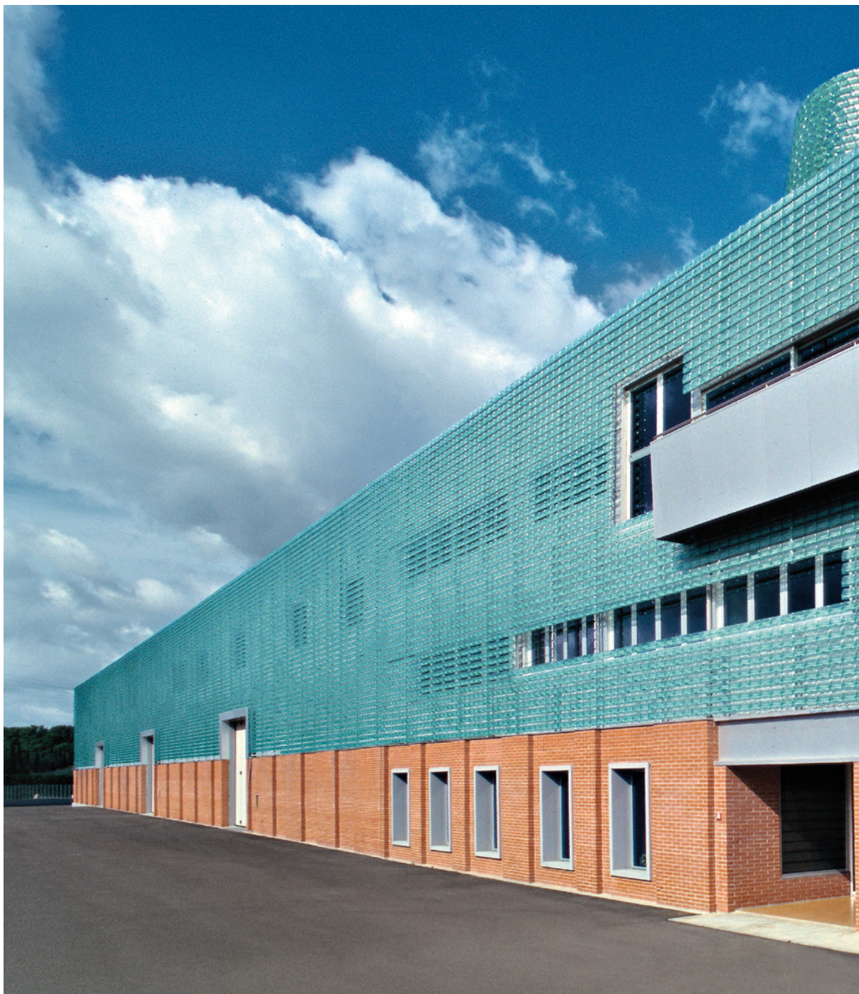
Sede direzionale di Montelupo Fiorentino, Firenze - Headquarter in Montelupo Fiorentino, Florence
