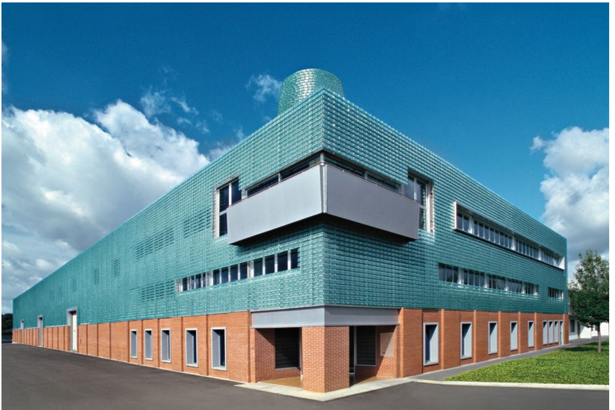
Sede direzionale di Montelupo Fiorentino, Firenze - Headquarter in Montelupo Fiorentino, Florence
