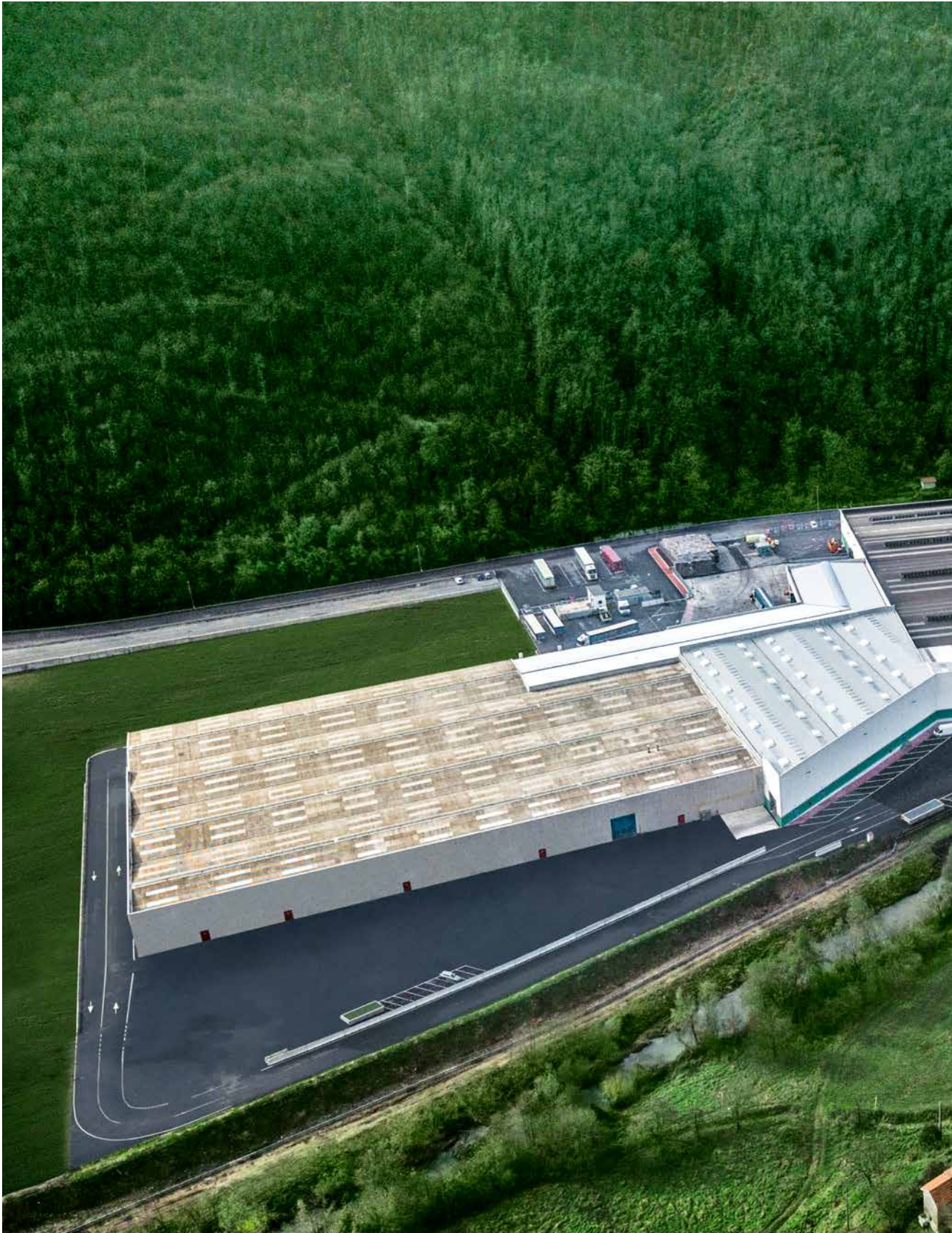
Stabilimento di Altare, Savona - Production plant in Altare, Savona
